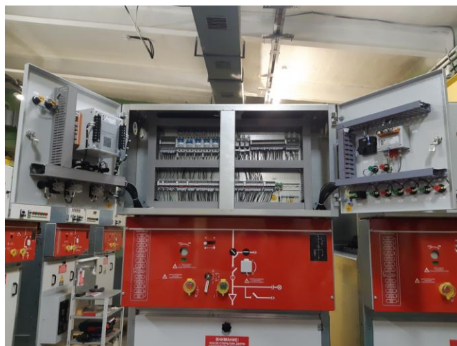
Отсек вспомогательных цепей шириной 1000мм
