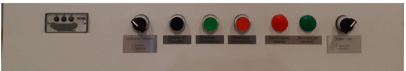
Индикатор наличия напряжения на токоведущих частях
