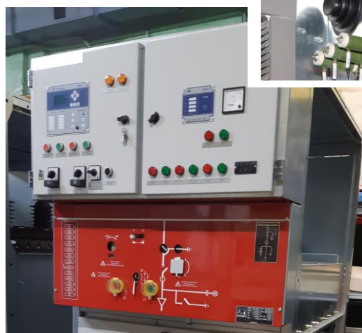
Отсек вспомогательных цепей шириной 1000мм
