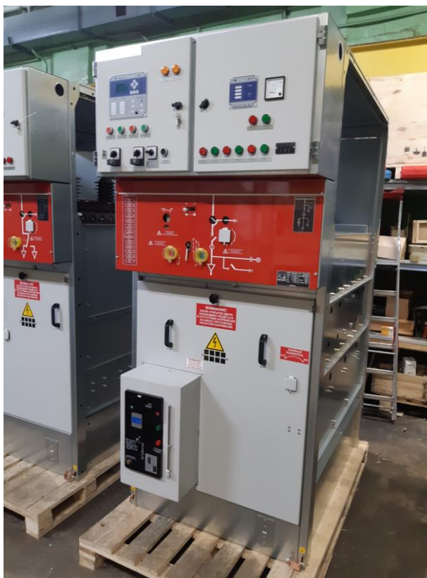
Корпус шкафа КСО «Горизонт-35»
